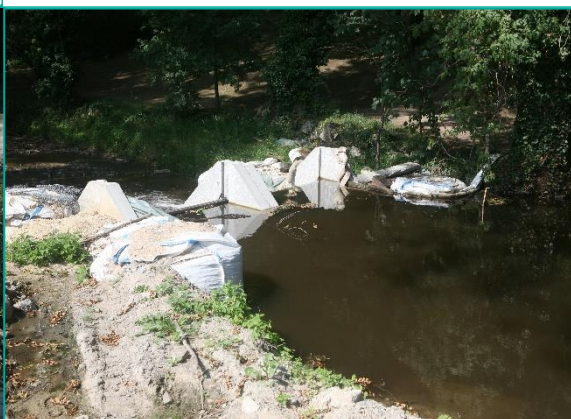
Seuil en préfabriqué (limitation du risque sédimentaire - installation provisoire)
