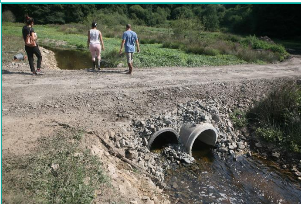
Chemin d'accès sur dérivation (provisoire) pendant les travaux
