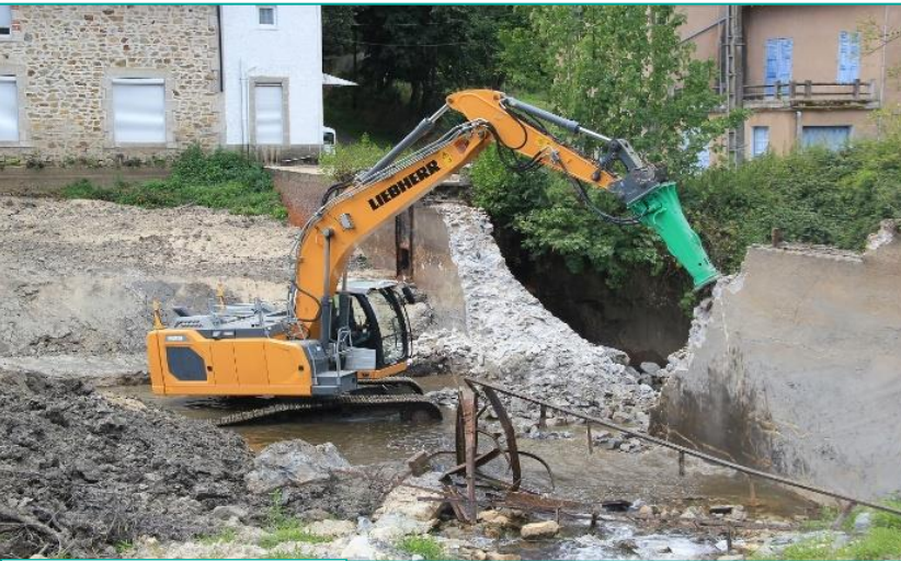
Le Vincou pendant les travaux
